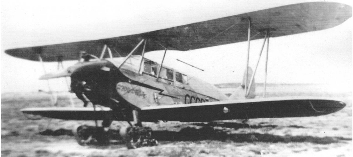
U-2: Seltene oder gar einmalige 2- oder 3-sitzige Limousinen-Version mit aerodynamischer Triebwerksverkleidung und „Raupefahrwerk“ im Dienst der Fluggesellschaft „AEROFLOT“
